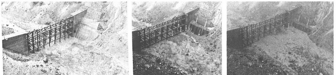
(a) 1983年7月27日の土石流の先端部 (b) 1985年7月21日の土石流の第1波の先端部 (c) 1985年7月21日の土石流の第1波の堆積状態
