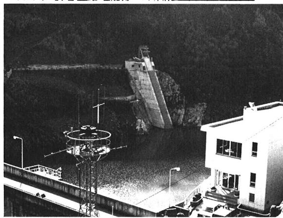
分安全であるという水理実験の結論を得た事により設計施工を完了した。従って 2.5D を 2.3D にまで経済設計基準として提案する。
