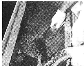
写真-1 弾性樹脂モルタル打設
