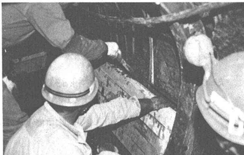
写真-3 レジンモルタルライニングPC上木の組み込みと裏込コンクリートの打設
