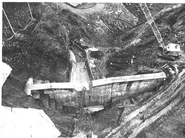
写真-1 砂防ダム全景
