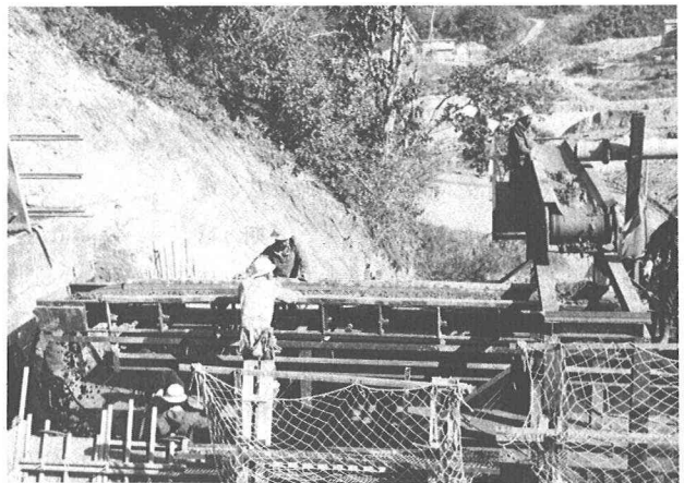
写真-3 コンクリート分配状況
