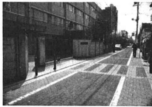
写真2 透水性ブロックの施工現場
