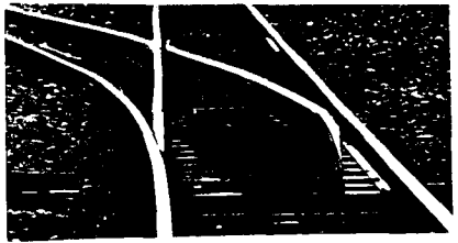
写真-1 一般的な鉄道分岐器
