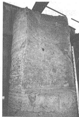
写真-1 ラップ切削した杭
