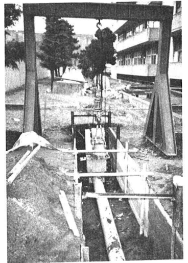
写真-1 埋設トレンチと加振機
