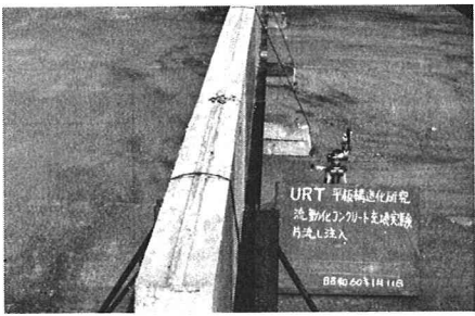
図-8 上表面仕上り状態
