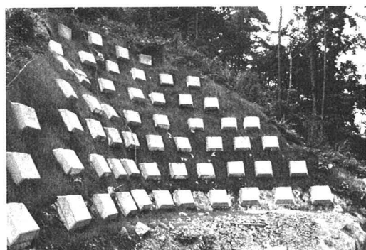
写真1 完成斜面(植生後)
