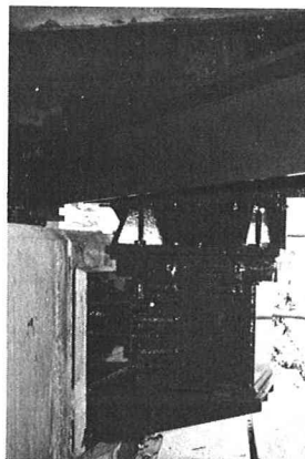
写真-1 ゴム支承とMS ストッパー
