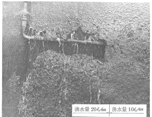
写真-2 吹付け後の状況
