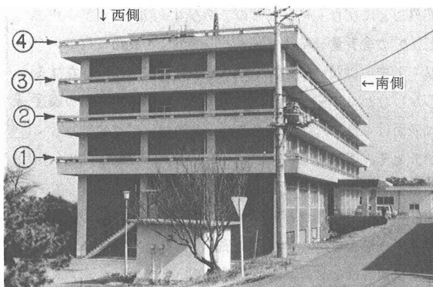
写真-1 4層のバルコニーとプレコン手摺りと束
