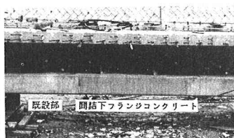
写真-2 間詰下フランジコンクリート
