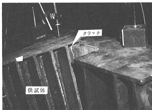
写真-2 崩壊時のクラック発生位置
