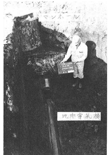
写真1. 到達した地中穿孔機
