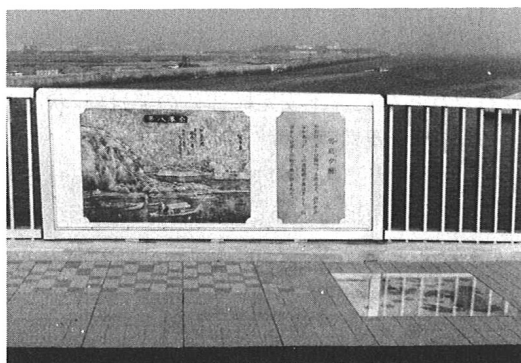
写真2：アルミ鋳造パネルの高欄取付状況と歩道の舗装
