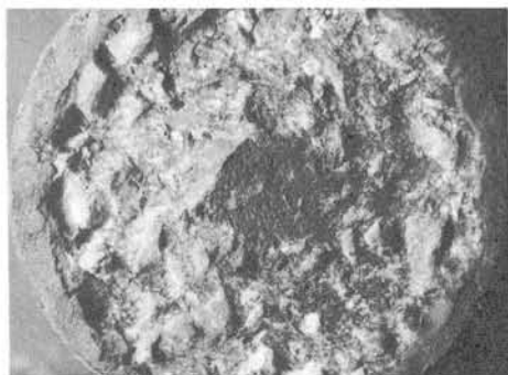
写真-3 摩耗した表面
