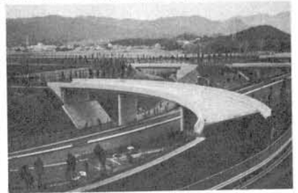
写真-1 3径間連続PC中空床版曲線橋
