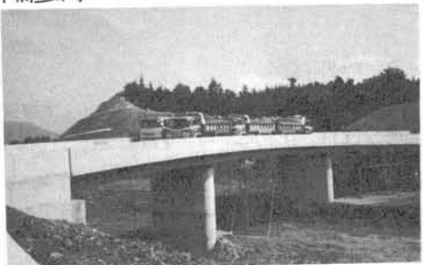
写真-2 実橋の載荷状況
