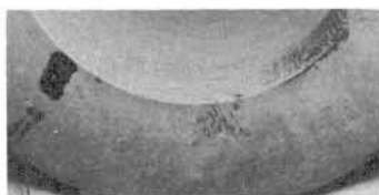
写真-2 普通セメントコンクリート 蒸気養生直後
