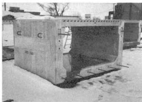
写真-1 継断面の鉄筋
