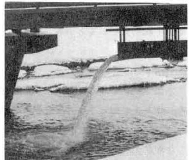
写真2 流末処理方法の一例(国鉄)
