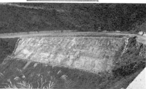
写真-4 工事完了
