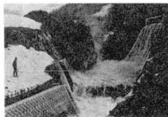
写真-1 衝撃型(笹倉第2発電所)
