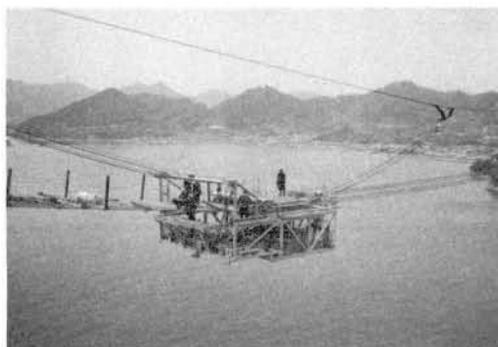
(写真-1) 床組架設作業状況
