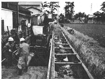
オープン水路に平行して鍍鉄管( l=6.0 m \phi 1,350 mm)埋設状況
