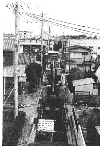
住宅密集地での New工(ON-II型)工法による管埋設状況
