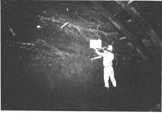
写真-1 注入により固結安定化した切羽
