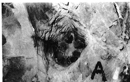
写真-1 芯抜起砕状況
