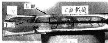
写真1. 上面板の疲労きれつの破面
