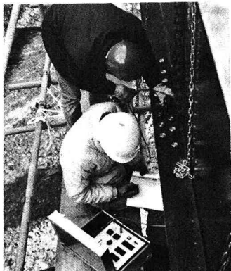
図-1 磁気軸力計での測定
