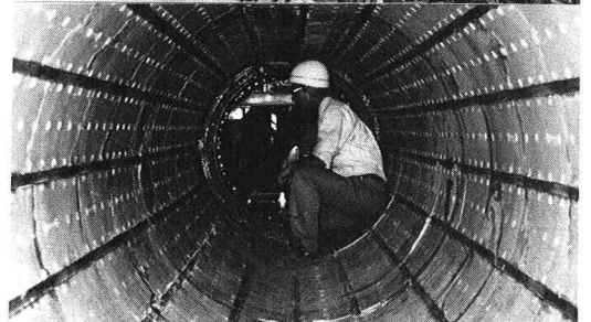
写真1, 2. 型枠装置及びライニング
