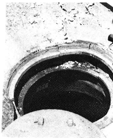
写真2 被害マンホール
