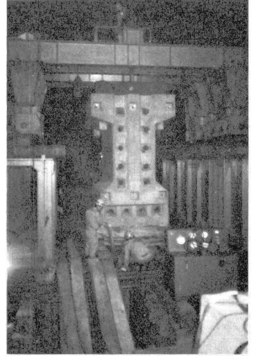
(写真-1) プレキャストブロックの架設
