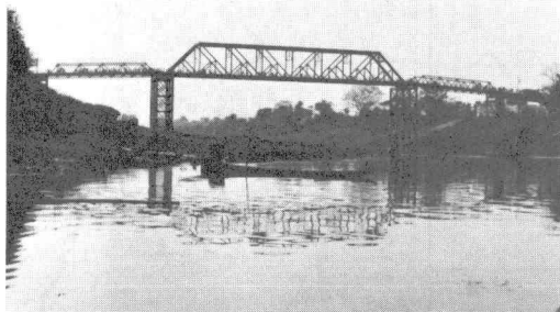
写真1. キン橋のトラス部分全景(上流側より撮影)
