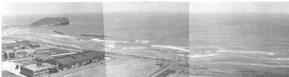
写真 カメラ位置から見たイタンキ浜と離岸堤
