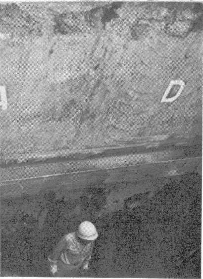
写真-2 パネルコンクリート硬化状態
