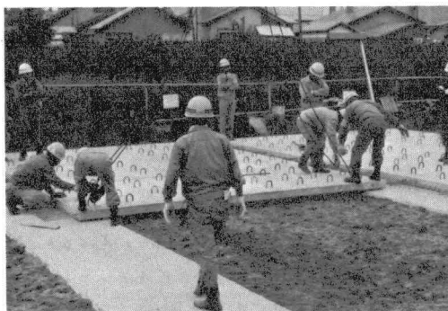
写真 PC版の設置状況
