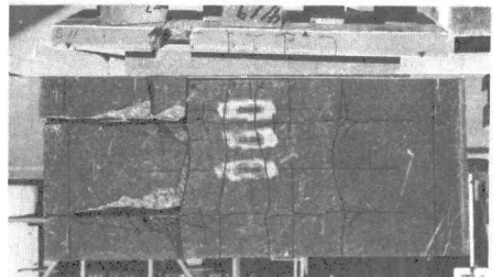
写真-3 縦ひび割れ (鉄筋)
