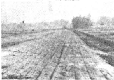
写真-3 工事場所転圧
