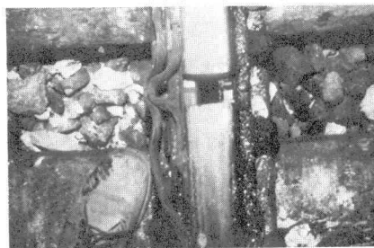
写真-1 犬釘の動き(トンネル内)
