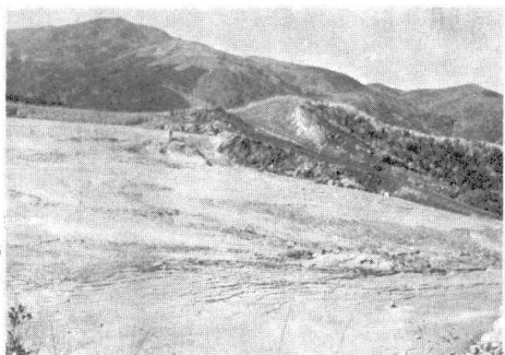
写真-1 破堤状況
