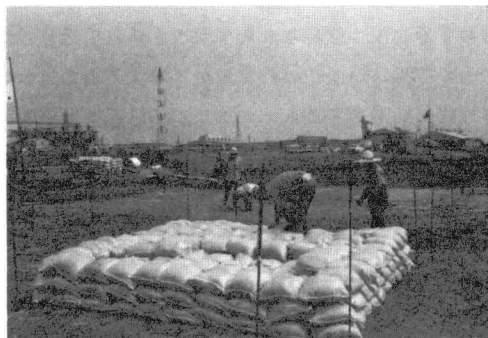
写真-1 原位置載荷試験
