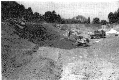
写真-1 安定処理土による施工
