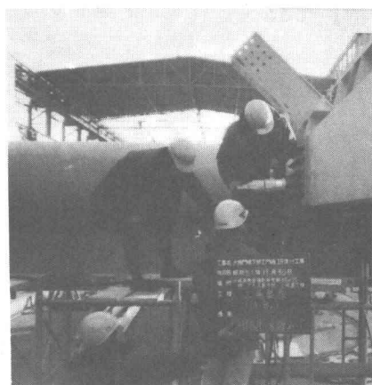
写真一2 電動ナットランナーによる締付け
