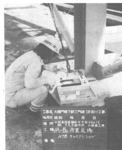
写真一2 電動ナットランナーによる締付け
