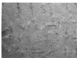
図-8 地点1の現場写真
