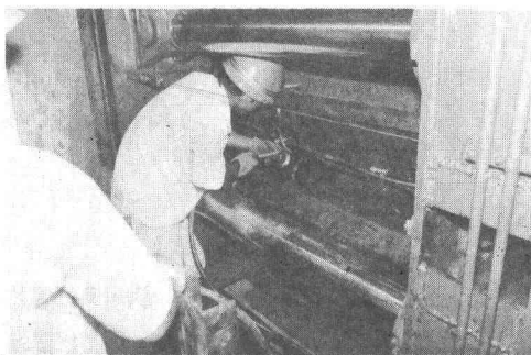
図3. トロックへのケーブル、油圧ホースの接続
