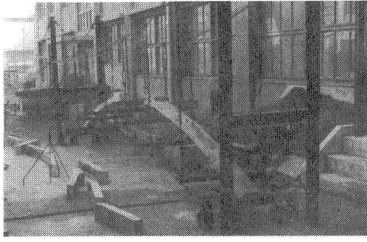
写真-3 基礎アーチリブの架設
