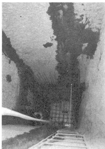
写真-1 地下連続壁内側
