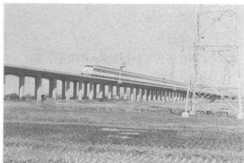
写真-1 試験箇所の状況
